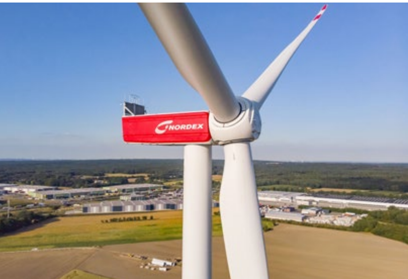
Nordex Windkraft- anlage Delta4000 N149/4.0-4.5 in Deutschland
